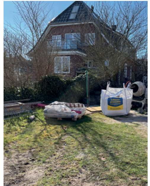
Baustelle im Garten
