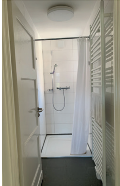
Neues Duschbad im Erdgeschoss
