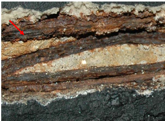
Abb. 22: innen; bereits starke Verluste des Bewehrungsmaterials. Die lamellenartige Auflösung des Eisens deutet auf die vollständige Korrosion hin
