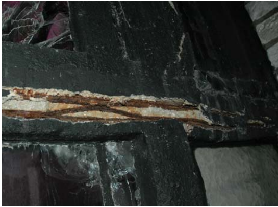
Abb. 20: innen; Betonabplatzungen im Bereich oberhalb korrodierender Bewehrung
