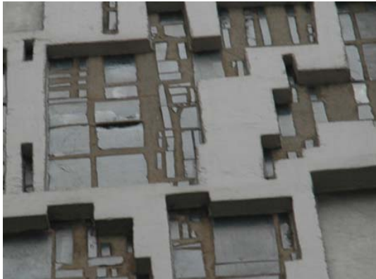
Abb. 2: hell gefasstes, durch Styroporquader verschaltes Oberflächenrelief und betonsichtige Binnenflächen der Basisverglasung; außen
