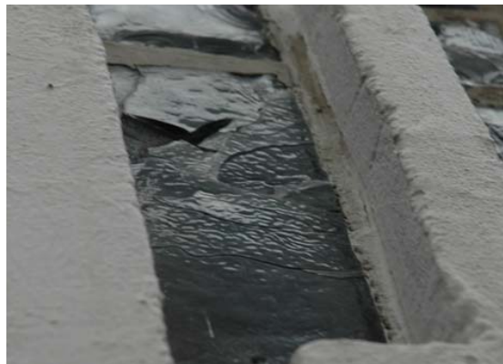
Abb. 17: außen; hohl liegende, verlustgefährdete Bereiche, die in naher Zukunft hinunter zu stürzen drohen
