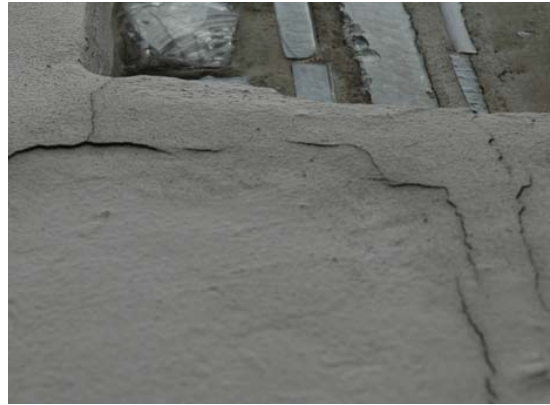
Abb. 21: außen; durch Korrosionsdruck entstandene Risse entlang von Segmentsfugen
