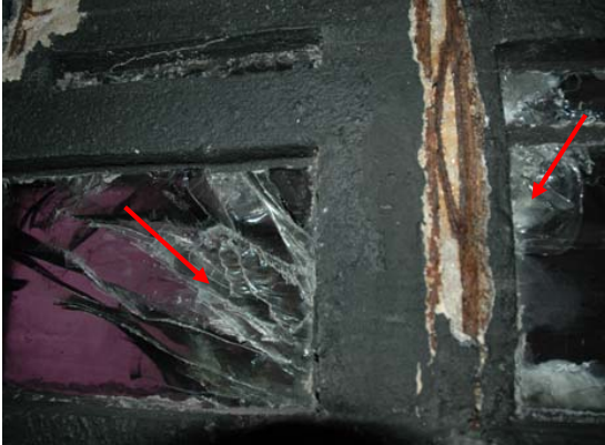
Abb. 14: innen; gravierende, durch Korrosionsdruck entstandene Schäden an den Gläsern
