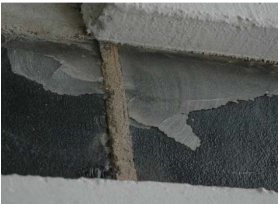
Abb. 16: außen; großflächige, verlustgefährdete Abmischungen an der Außenseite der Gläser
