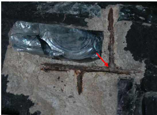
Abb. 13: innen; freiliegender Bereich der Bewehrung einer Binnenfläche; hier deutlich die Punktschweißung zu erkennen
