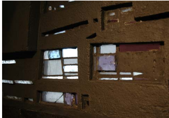
Abb. 3: dunkel gefasstes, durch Styroporquader verschaltes Oberflächenrelief; dunkel gefasst; innenseite
