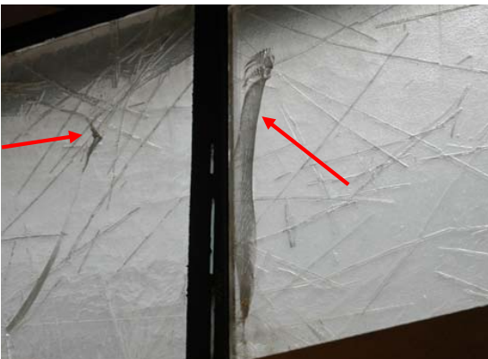
Abb. 18: innen; erhebliche Sprungbilder in den großformatigen Gussgläsern
