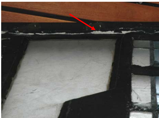
Abb. 24: innen; hinter der Holzvertäfelung sichtbar werdender, obere Abschluss aus Styropor, verputzt
