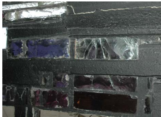
Abb. 19: innen; ein von Sprungbildern stark betroffener Bereich
