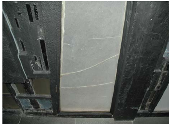
Abb. 9: große, in Winkelrahmen eingekittete Gussgläser
