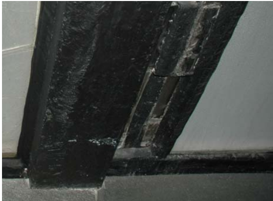
Abb. 23: innen; durch die Gestaltung kaschierter H-Stahlträger
